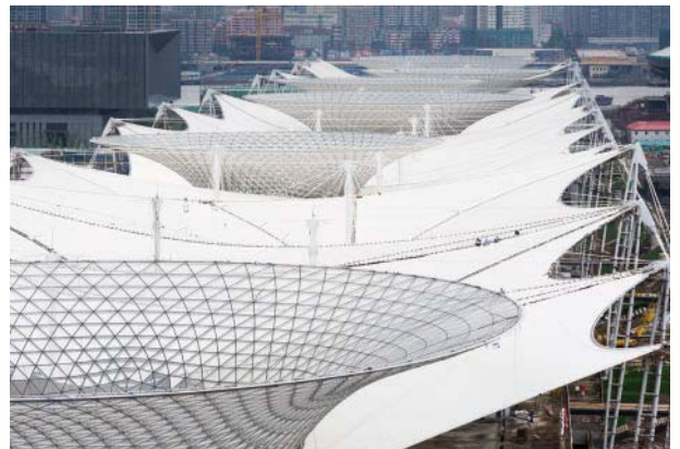
Dachkonstruktion, bestehend aus 6 Sun Valleys und dem Membrandach mit insgesamt 65.000 Quadratmetern Fläche
