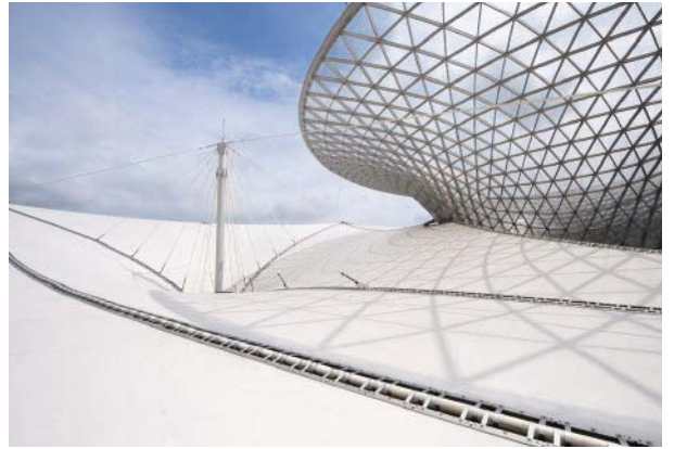
Die Konstruktion der Sun Valley berücksichtigt Eigengewicht, Wind, Schall, Erdbeben und die Lasten der Membrane.
