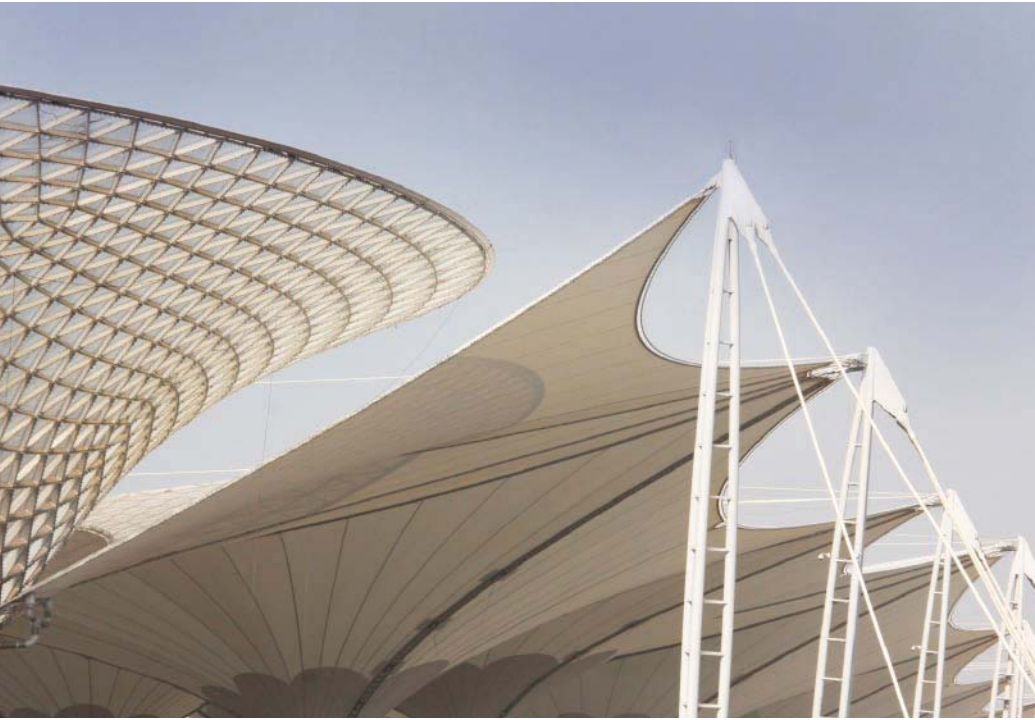
Stahl-Glas-Trichter und Membrandach mit insgesamt 31 Außenmasten
