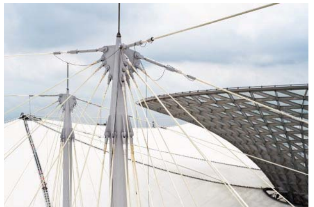
Mastkopf mit 3 mal 4 Hängeseilen und 3 Kopfseilen
