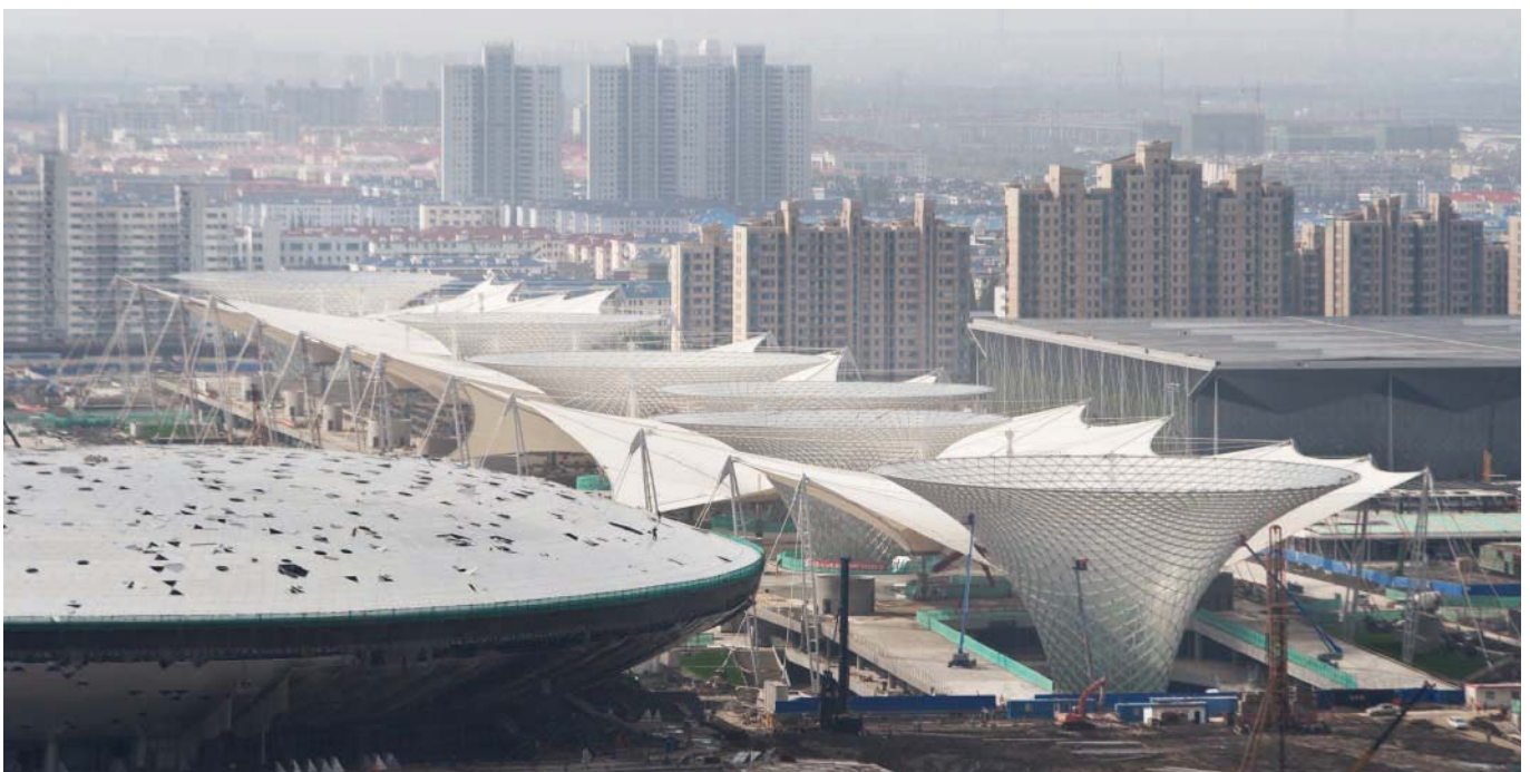
Überdachung der Expo-Achse mit einer Abmessung von 1.000 mal 100 Metern
