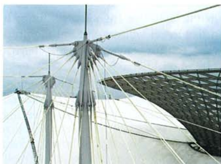
Bild 2. Mastkopf mit 3 × 4 Hängerseilen und 3 Kopfseilen
