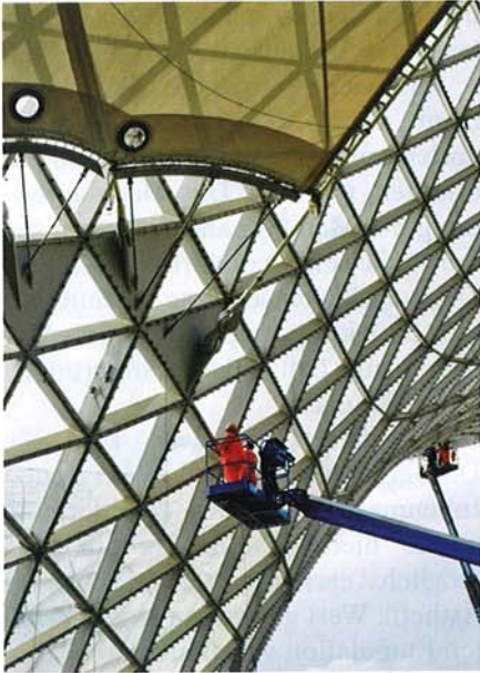
Bild 4. Komplexe Dateilausbildung der Membrananschlüsse an den Sun Valleys
