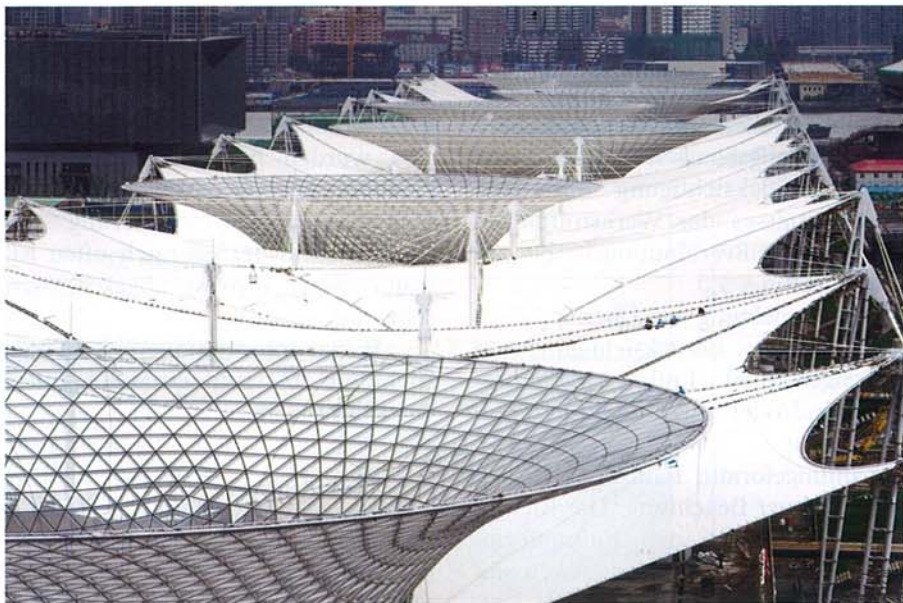
Bild 1. Dachkonstruktion aus sechs Sun Valleys und dem Membrandach
