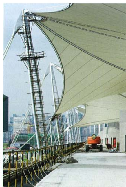
Bild 3. Außenmast mit Rückverankerung hält die Hauptlast der Membrane
